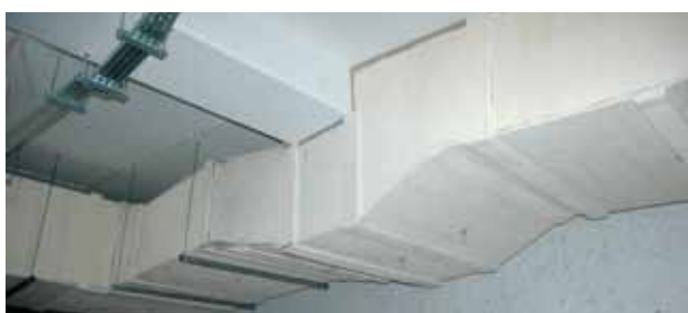
Detal G - Przejście przewodu przez przegrodę
