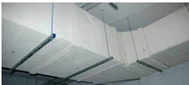
Detal C - Przekrój podłużny przez przewód o szerokości nie większej niż 2460 mm
