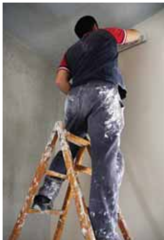
用填缝料处理隔墙（上图）和与吊顶连接处（左图）的板缝。
