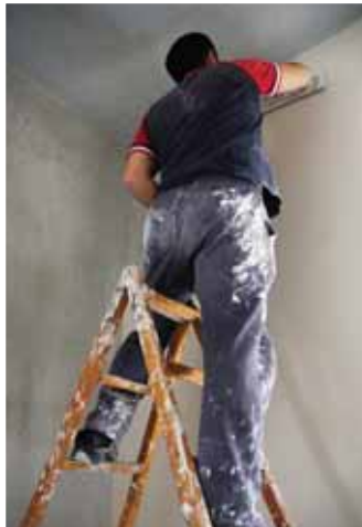
用填缝料处理隔墙（上图）和与吊顶连接处（左图）的板缝。
